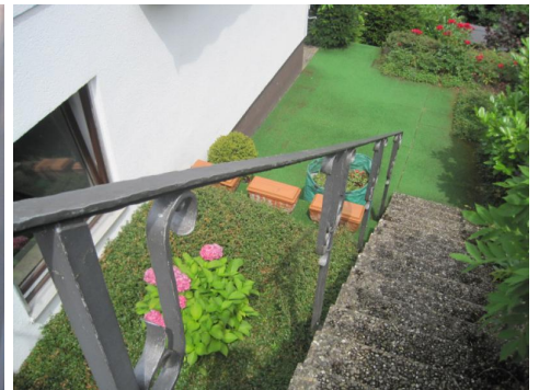
Treppe und Terrasse zum UG
